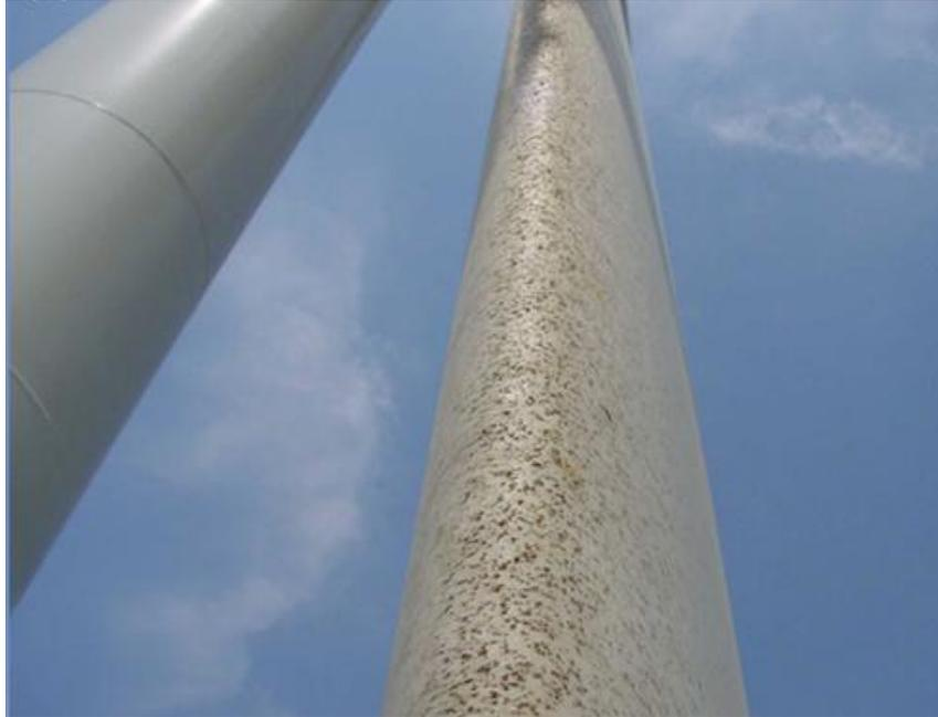
Figure 24: Restes d'insectes sur les pales d'une éolienne (Voigt et al., 2021)
